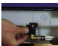
Montage d'un raccord MasterFix sur l'arrivée d'eau de bâti-support pour WC en 1/2".
