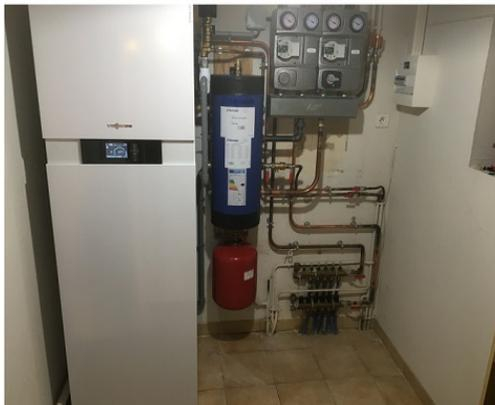
*Remplacement d'une chaudière fioul par une pompe a chaleur de marque Viessmann Vitocal 222 très silencieuse avec production d'eau chaude sanitaire et régulation Vitotronic 200 tactile en fonction de la température extérieure. Mise en place d'une bouteille de mélange qui distribue 2 zones: circuit pour plancher chauffant et circuit direct radiateurs. Désembouage des circuits et pose d'un pot a boue magnétique avec filtre et traitement par inhibiteur de corrosion de chez Coroxyl.*
