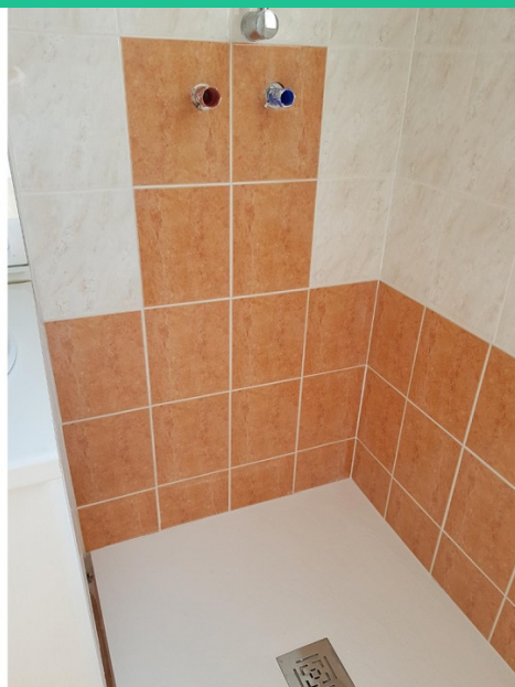
Avant travaux espace douche
