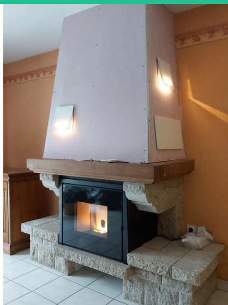
En cours de d'installation
