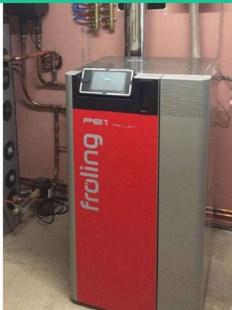
Avant travaux chaufferie
