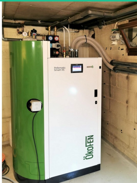
Prises d'aspiration des pellets
