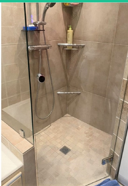
Début des travaux
