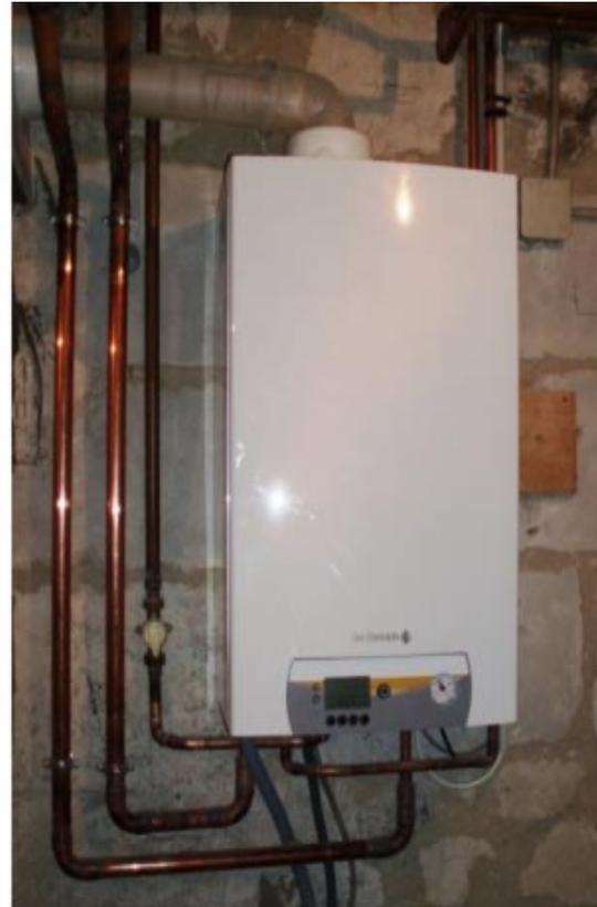
*Remplacement d'une chaudière gaz au sol par une chaudière gaz à condensation intégrant une production d'eau chaude sanitaire.
