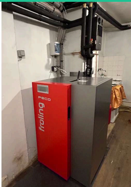
Silo cube à granulés d'une capacité de 500 kg
